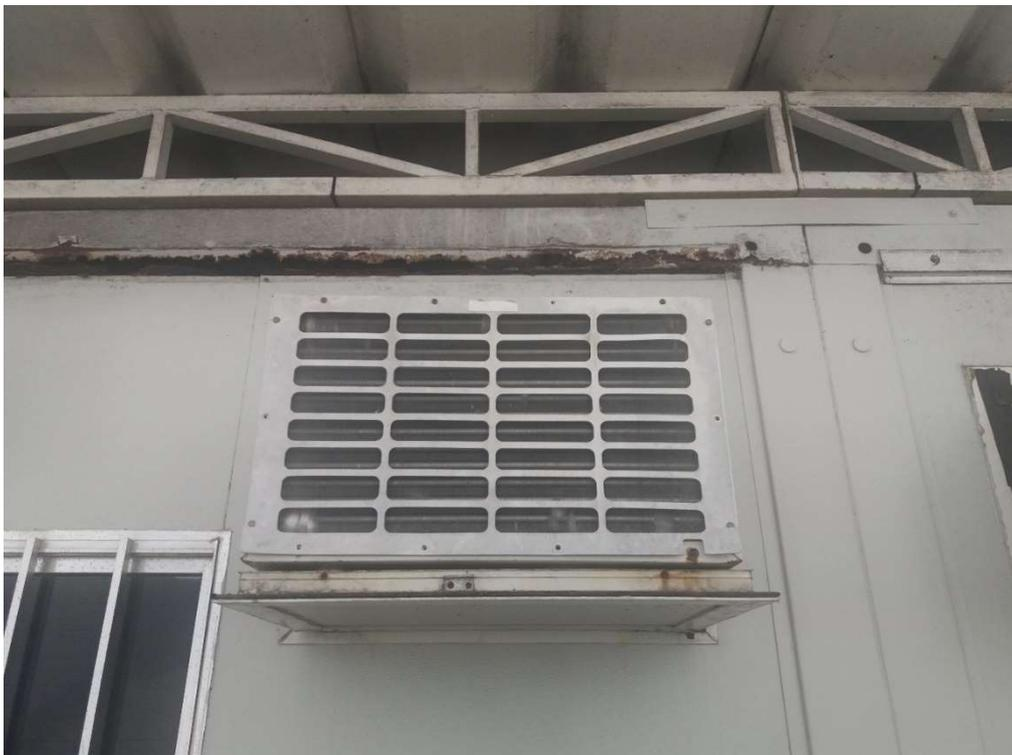
Foto 2 - Estrutura superior deteriorada
