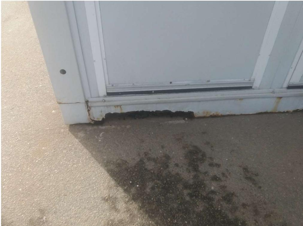
Foto 1 - Estrutura inferior deteriorada
